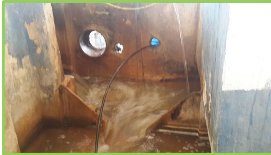
Figura 11. Vertedero triangular para mezcla rápida planta antigua.
