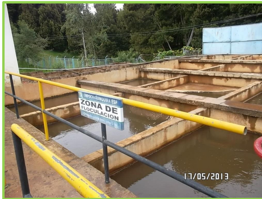
Figura 14 Floculador Hidráulico planta nueva
