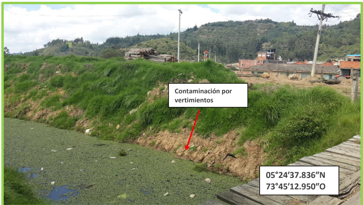
Figura 32 Vallado madre Sur antes de unirse con la Quebrada Bautista.
