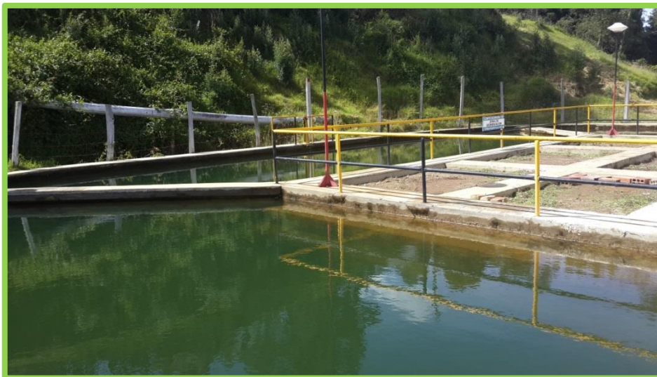
Figura 15. Sedimentador de la planta antigua.
