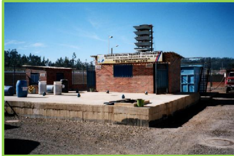
Figura 21 Planta de tratamiento primero de septiembre
